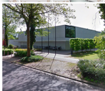
11: Cafeteria Sportpark: dringend nood aan renovatie
